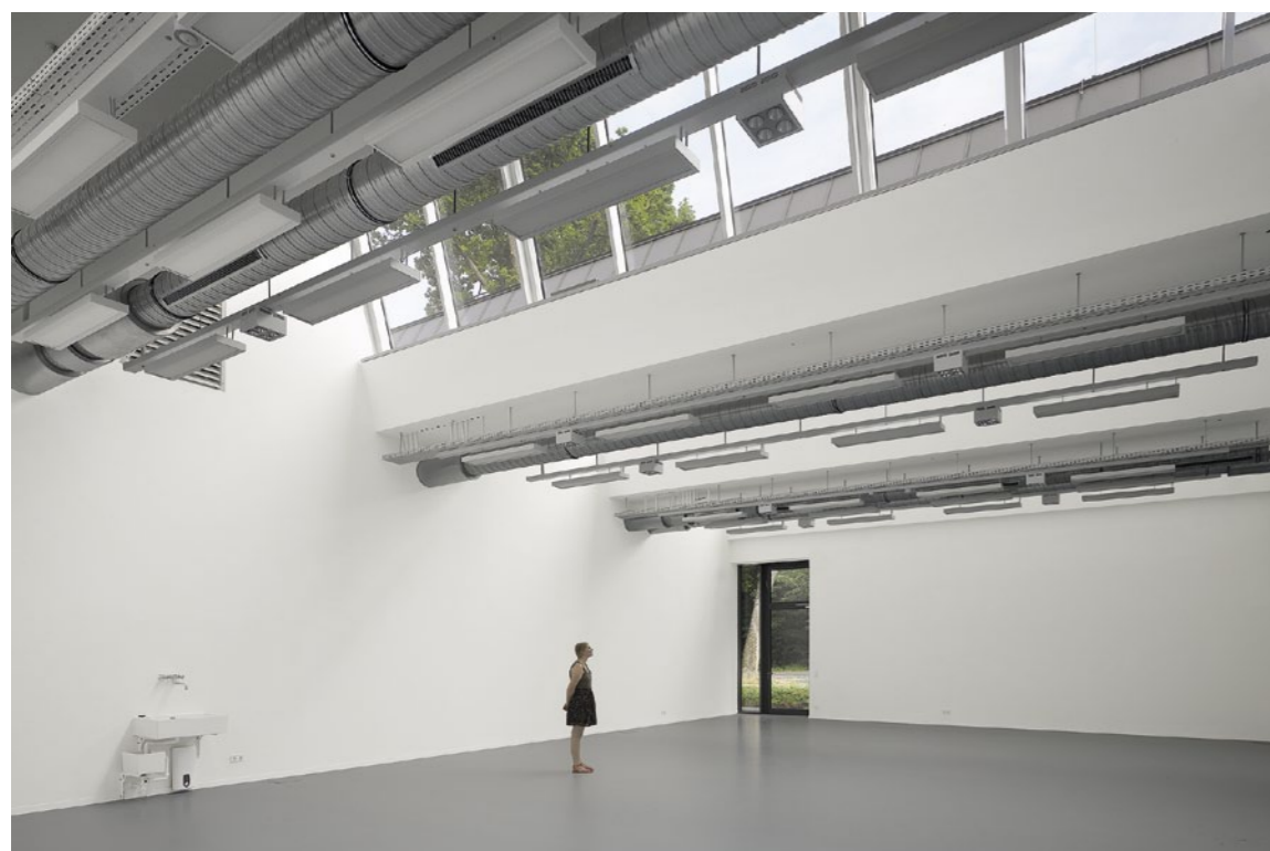
Durch die vier großen Sheds gelangt schlagschatten-freies Nordlicht in den Großen Malsaal.
