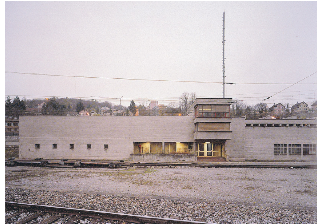
Stellwerk und Dienstgebäude in Schaffhausen von Max Vogt, 1968
