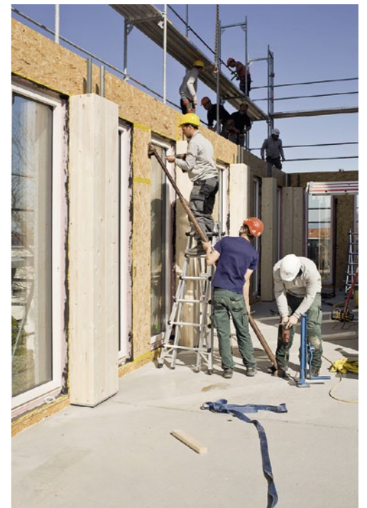
Montage der Holzbetonverbund-Decken (links) und der Fassadenelemente (oben) auf der Baustelle. Der Verbindungsdorn der Holzstützen wird im Fertigteil eingegossen.
