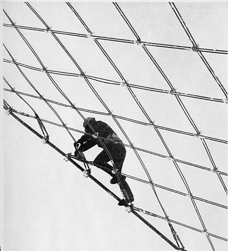
26 Montage des Seilnetzes für die Probedachfläche (ungespannter Zustand)
