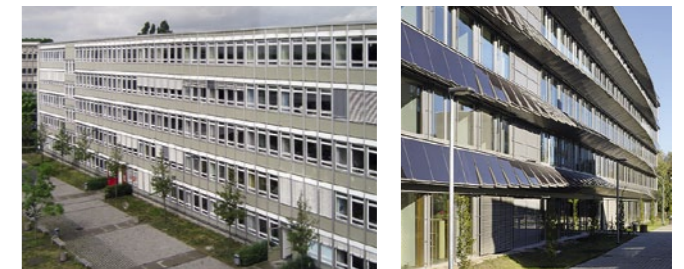
OSZ Energiewirtschaft | Sanierung: p2mberlin, Berlin
