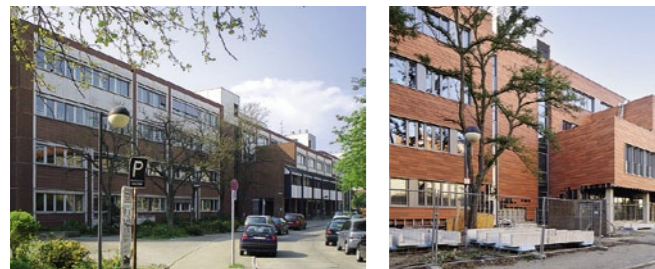
OSZ Maschinen- und Fertigungstechnik | Sanierung: Farwick+Grote, Ahaus
