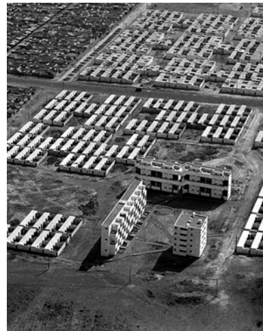
Der Résident Général Francis Lacoste inspiziert das Viertel Carrières Centrales in Casablanca am 18. Juni 1954. Oben: Luftaufnahme der Baustelle (1953), im Vordergrund die „Cité Verticale“ von Candilis und Woods.
