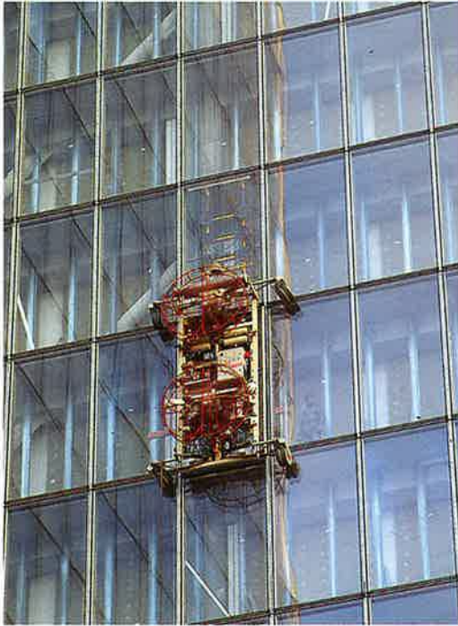
Für die Montage und Wartung der Fassaden wurde eine neuartige Arbeitsbühne entwickelt: Pal Heli
