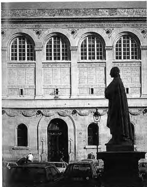
Sichtbetonpfeiler im großen Lesesaal Rez-de-Jardin (2. Untergeschoß). Fassadenausschnitt der Bibliothèque Sainte Geneviève von Henri Labrouste an der Place du Panthéon
