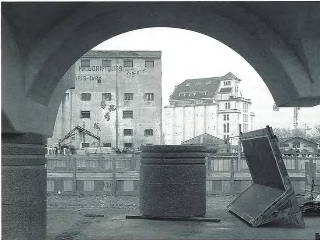
Im Südosten der Bibliothek stehen mitten im Neubaugebiet Seine Rive Gauche die alten Mühlen von Paris. Sie werden erhalten und für eine „Cité des Arts“ umgenutzt. Im Vordergrund lagern Betonfertigteile für den neuen RER- und Météor-Bahnhof Tolbiac-Masséna
