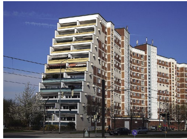
Links: Fassadengestaltung in Schmarl (Jürgen Deutler, 1976–79); rechts: Wohnblock des Typs WBS 70 AR mit Stufengiebel in Evershagen (Entwurf: Peter Baumbach) Fotos: Matthias Grünzig
