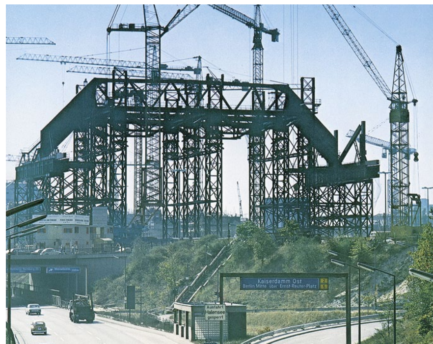
Baustelle des ICC Berlin Foto: AMK Berlin
