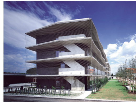
Das mit dem deutschen Architekturpreis 2007 ausgezeichnete Münchner Studentenwohnheim von Fink + Jocher (Heft 27–28.05) sieht die Jury als „wegweisende Lösung für studentisches Zusammenleben“. Sie lobte zugleich das Energiekonzept des Gebäudes: es sei durch die geschickte thermische Anordnung von Außen- und Innenräumen beispielhaft für Energieeffizienz und Klimaschutz.
