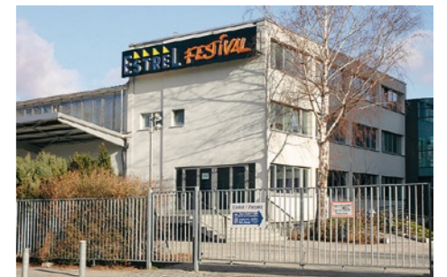
Das Estrel-Festivalcenter entstand 1997 in einer umgebauten Industriehalle. An sechs Tagen pro Woche findet dort die Show „Stars in Concert“ statt. Das Estrel-Conventioncenter, Teil drei des Estrel-Komplexes, bietet 15.000 Quadratmeter Fläche für Messen, Tagungen und Parteitage.
