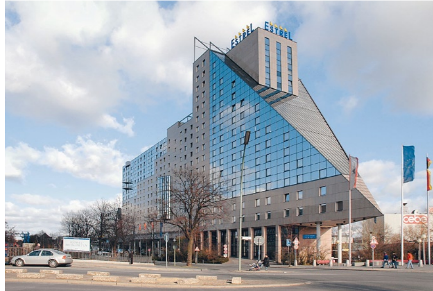
Die sieben Tower Apartments über dem Ritz-Carlton am Potsdamer Platz, (Architekten Hilmer & Sattler und Albrecht, Berlin/München, linker Turm), stehen noch immer zum Verkauf. Das dahinterliegende Marriott entstand nach Plänen von Bernd Albers, Berlin. Unten: Mit 1125 Zimmern ist das Hotel Estrel das größte in Deutschland.
