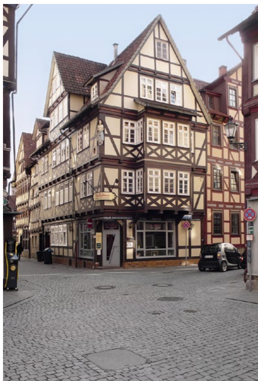
Weiterbau der Fachwerkstadt um 1950: Anstelle des 1945 abgebrannten Vorgängerbaus entsteht ein neues, in konstruktivem Fachwerk gebautes Wohn- und Geschäftshaus als spätes Zeugnis der jahrhundertalten Bautradition von Hann. Münden
