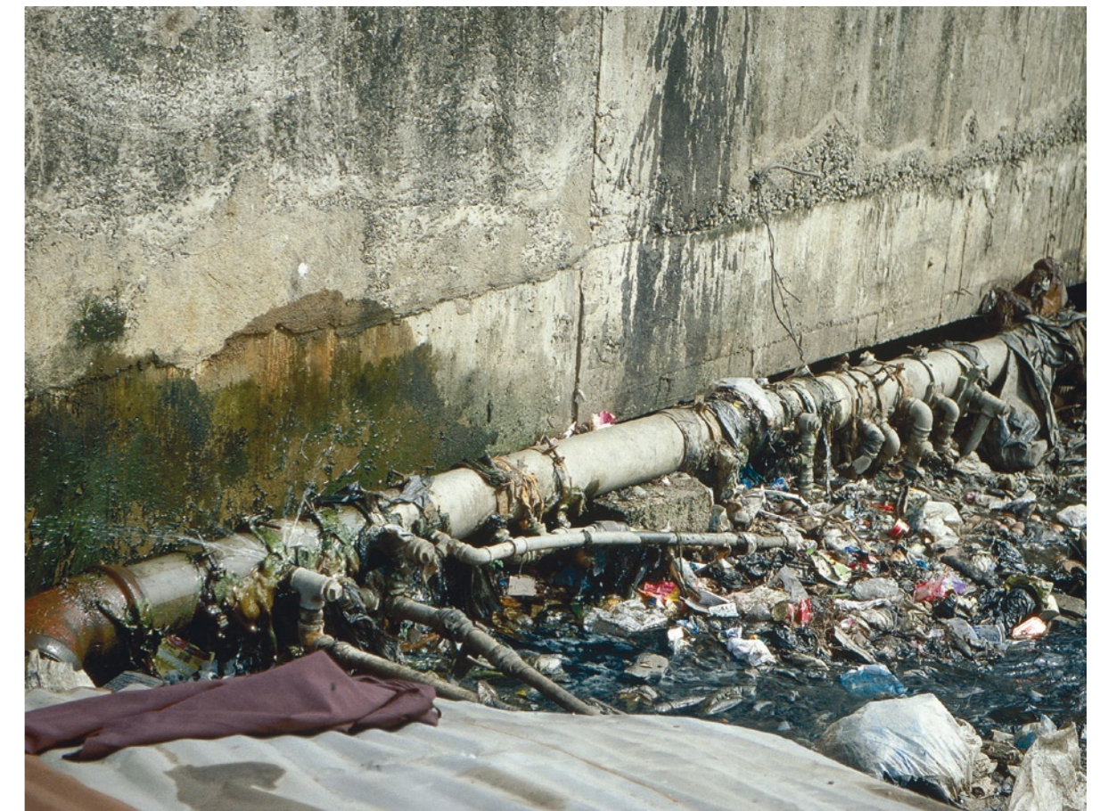
An einer namenlosen Ausfallstraße Richtung Norden werden nicht mehr fahrtüchtige Autos abgestellt und die Wracks Zug um Zug bis zum allerletzten irgendwie verwertbaren Material ausgeschlachtet. Die Gerippe und der Restmüll bleiben zurück. In den betonierten Abwasserkanälen finden auch die Frischwasserleitungen Platz.
