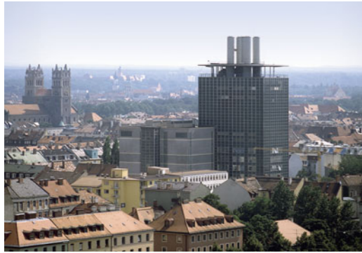
Als einziges innerstädtisches Hochhaus der Nachkriegszeit dominiert der Maschinenhausturm des Heizkraftwerks an der Müllerstraße die Münchner Stadtsilhouette. Die Aufnahme mit Blick nach Südosten entstand 1995. Foto: © SV-Bilddienst, Schillinger K.
