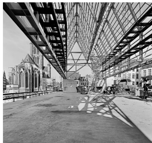
Die Konstruktion: eine Brücke aus Stahlträgern, innen mit Holz verkleidet, außen mit Holz und Glasschindeln
