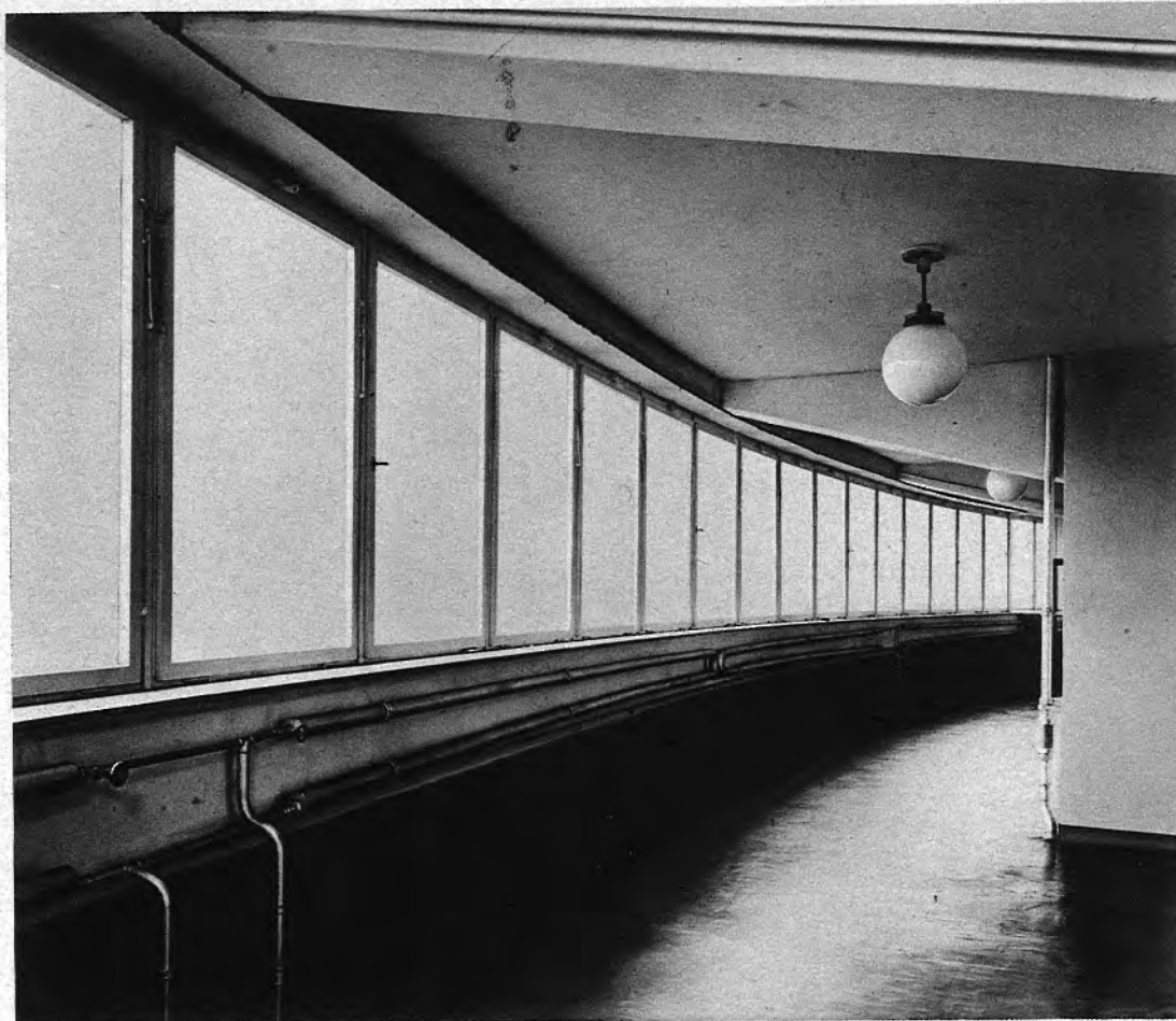
Kragkonstruktion in den Ge- schossen
