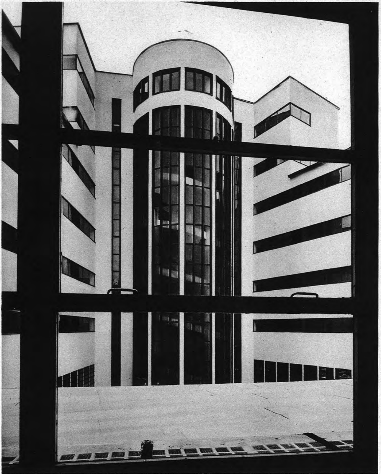
Blick aus der Setzerei gegen den Treppenturm im Hof
