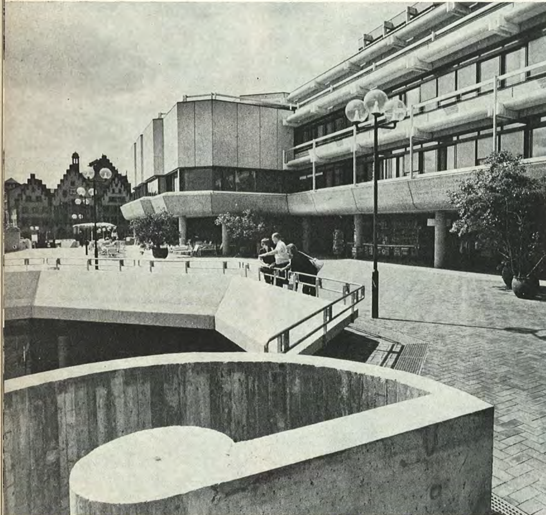
Blick über den Fußgängerbereich vor dem offenen, mit Läden, Cafés usw. besetzten Erdgeschoß des Technischen Rathauses hinüber zum Römer. Vorn die Treppe hinunter zum „Historischen Garten“. Vergleiche auch Umschlagbild
