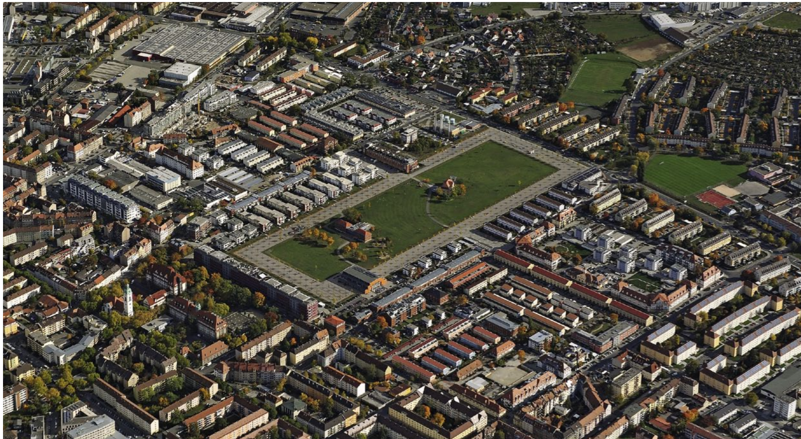
Die ehemaligen Darby-Barracks in der Fürther Südstadt, Blick von Nordwesten. Im Süden anschließend die einst von der US Army genutzte Kalb Housing Area
