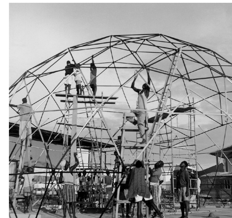
Anlässlich der Independence Exhibition in Lagos erhielten Godwin and Hopwood 1960 den Auftrag für zwei Ausstellungspavillons, die in kürzester Frist fertig gestellt werden mussten. Für den Eastern Nigerian Pavilion war eine Tragkonstruktion aus Tropenholz vorgegeben, er wurde
