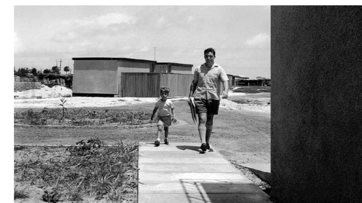
Seit 1973 arbeiten Godwin und Hopwood am Entwurf für eine Glasfabrik im Auftrag eines japanisch-britischen Konsortiums in Agbara, 30 Kilometer außerhalb der Stadtgrenzen von Lagos. Die Fabrik selbst wurde zwar 1974 gebaut, doch die
