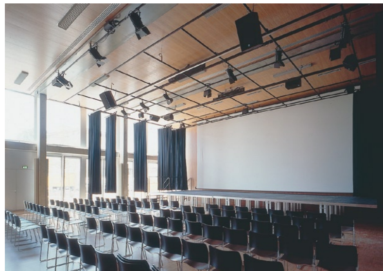
Das Tragwerk, ein konventionelles Stützen-Platten-System, ist mit Sichtbetonwandscheiben ausgesteift und mit nichttragenden Glasbaustein- oder verputzten Backsteinwänden ausgefacht. Unten Aula und Mensa, auf der rechten Seite der Werkbereich im südlichen Gebäude
