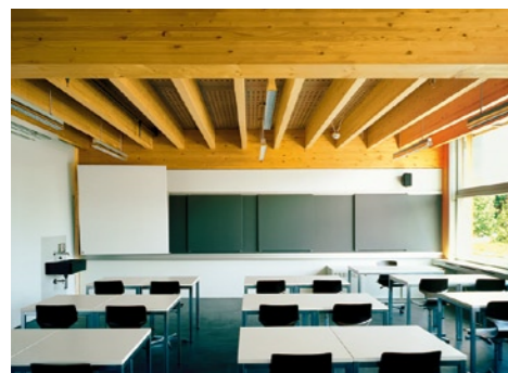
Die Deckenbalken laufen in den Klassenzimmern längs und erlauben so, dass die Vertikalschiebefenster bis zur Decke geöffnet werden können. Darüber die Turnhalle, rechts ein Gang im Klassenzimmertrakt
