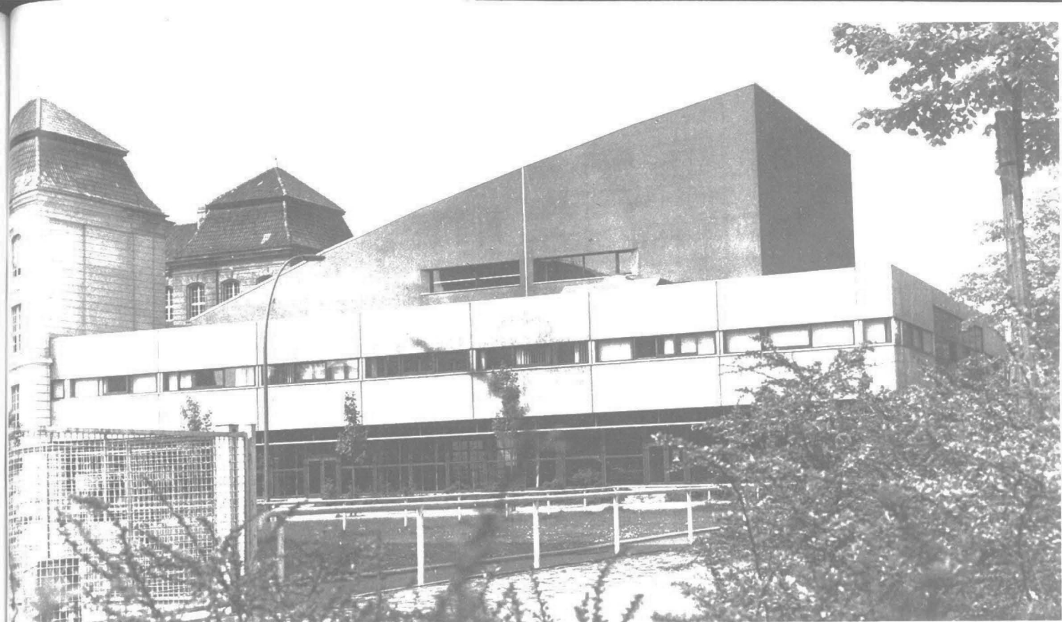
Das Theaterstudio mit dem Anschluß an den erhalten gebliebenen Mittelbau
