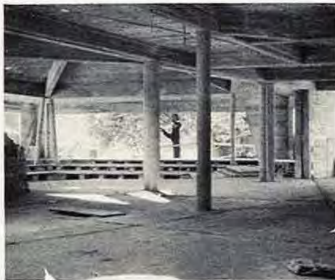
▲ Aula im Rohbau, aus der Halle gesehen. Darüber ein Blick vom Gemeindezentrum auf die Klassen der Unterstufe und der Oberstufe „auf der Platte“. Im Hintergrund das alte Stadthaus (zum Umbau als Realschule vorgesehen) (Foto Kramer, Lünen)
