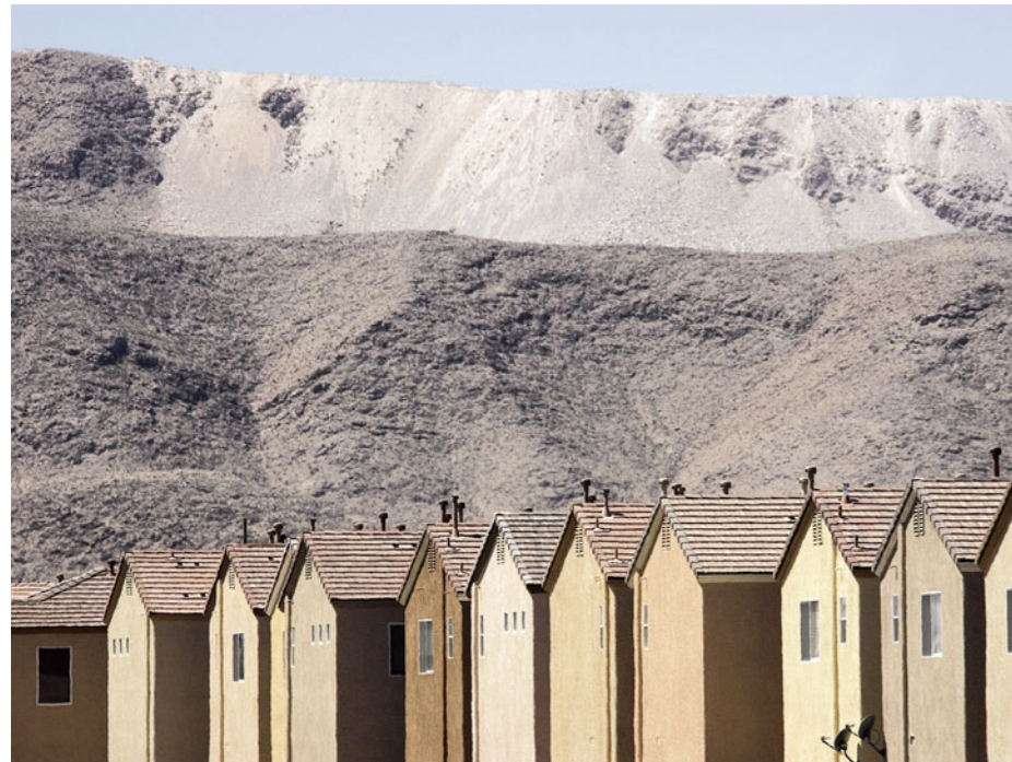
Oben: St Rose Parkway am Südrand von Henderson transformierte sich von einer kleinen Straße zur wichtigen Verkehrsader. Neben Casinos stehen lange Reihen von Low-end-Housing.
