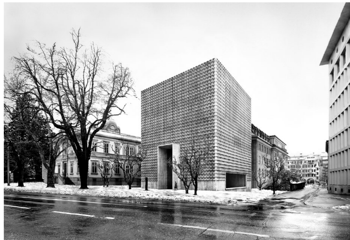
1. Rang | Barozzi Veiga bauen den Neubau auf der Axialsymmetrie der Villa Planta auf. Eine lange Treppe führt zu den Ausstellungsräumen in den Untergeschossen. Vorgeformte perlgraue Betonelemente bilden die Außenhaut. Schnitt und Grundriss 1. UG im Maßstab 1:1000
