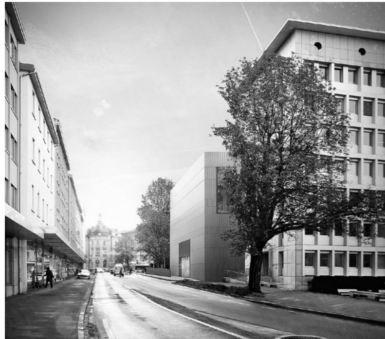
4. Rang | Buchner Bründler erschließen die Museen vom Postplatz. Den Neubau hüllen sie in einen Schalenmantel aus keramischen Stäben. Die reduktionistische Strategie erfordert in den Augen der Jury eine Präzision, die sie aber vermisse.
