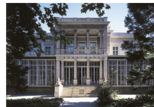
Die nach dem Bauherrn Jacques Ambrosius von Planta benannte Villa wurde 1874–75 vom Architekten Johannes Ludwig als private Residenz erbaut. Kurz vor seinem Tod verkaufte Planta 1898 das Haus an die Rhätische Bahn, die es ab 1919 für kulturelle Zwecke an den Kanton Graubünden vermietete. Foto und Luftbild: Auslobung
