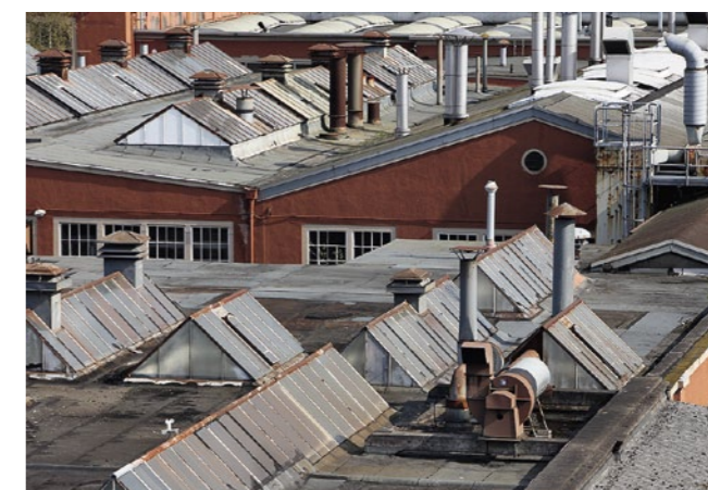
Das Pfaff-Areal im Südwesten der Innenstadt von Kaiserslautern: Bis auf vier Bauten sollen alle Gebäude und Fabrikhallen abgerissen werden. Unten: Das revitalisierte Gelände nach den Plänen der European-Preisträger aus Holland
