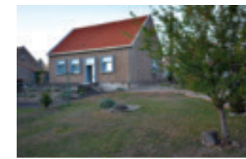
Wiederaufbau in Creutzwald
