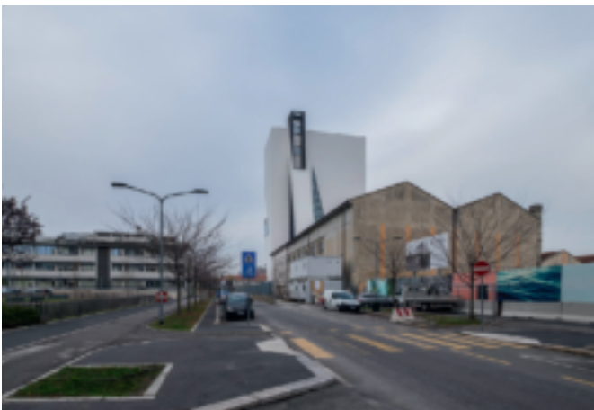
Die Rückseite des Torre mit dem Aufzug und der stützenden Strebe, die das Dach der benachbarten Lagerhalle durchbohrt. Oben: Ausstellungssaal auf Ebene 3. Walter De Maria, Bel Air Trilogy, 2000–
