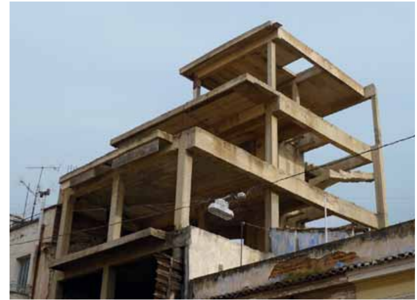
Die „Polykatoika“ ist die griechische Umsetzung von Le Corbusiers „Dom-ino“: ein Stahlbetonskelett mit Treppenhaus und Aufzugschacht, das sich flexibel aus- und umbauen und scheinbar endlos in die Höhe erweitern lässt
