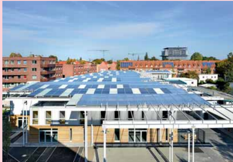
Unter dem Dach liegen die modularen Werkhallen in Reihen nebeneinander. Dazwischen bilden sich Werkhöfe aus, die vom Dach gegen Witterungseinflüsse geschützt sind. Fotos: IBA Hamburg GmbH/Martin Kunze
