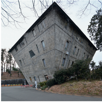
Umgekehrte Pyramide aus Beton: Seminargebäude der Inter-University bei Tokio; Takamasa Yoshizaka, 1965
