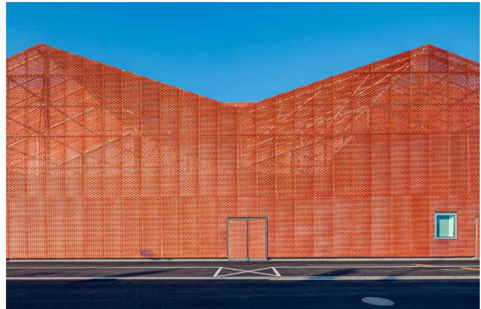
An den Fassaden sind die unterschiedlichen Nutzungen nicht ablesbar. Nur einige Öffnungen heben sich ein wenig hervor.
