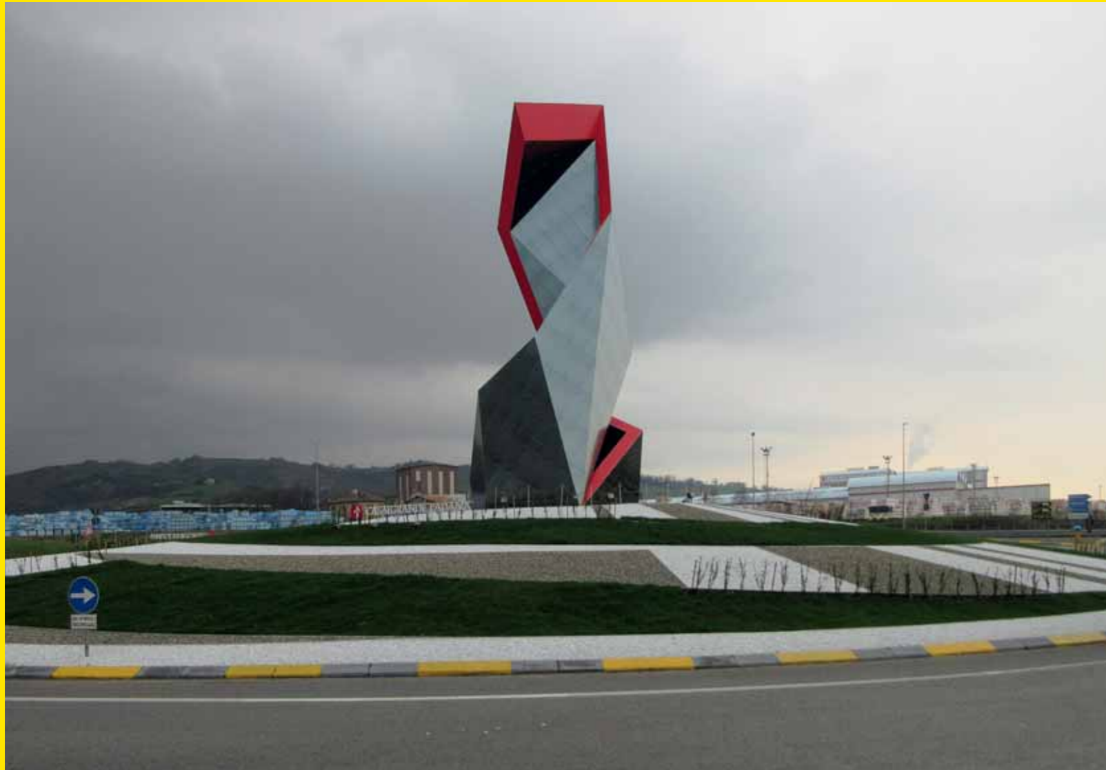
Im Kreisverkehr von Casalgrande steht „The Crown“ von Daniel Libeskind. Die silbernen Keramikplatten werden bald auch an der Fassade seines Neubaus „Sapphire“ in Berlin zu sehen sein.
