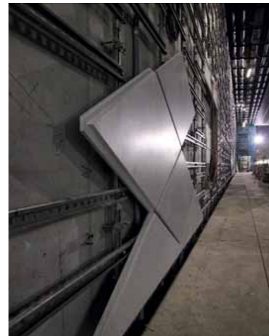
Das Kontinuum: 6700 Rauten und Sonderteile, die mit der CNC-Säge aus Vakuum-Filter-gesprestem Betonplatten ausgesägt wurden. Zeichnung: netzwerkarchitekten; Foto unten: Heike Klussmann
