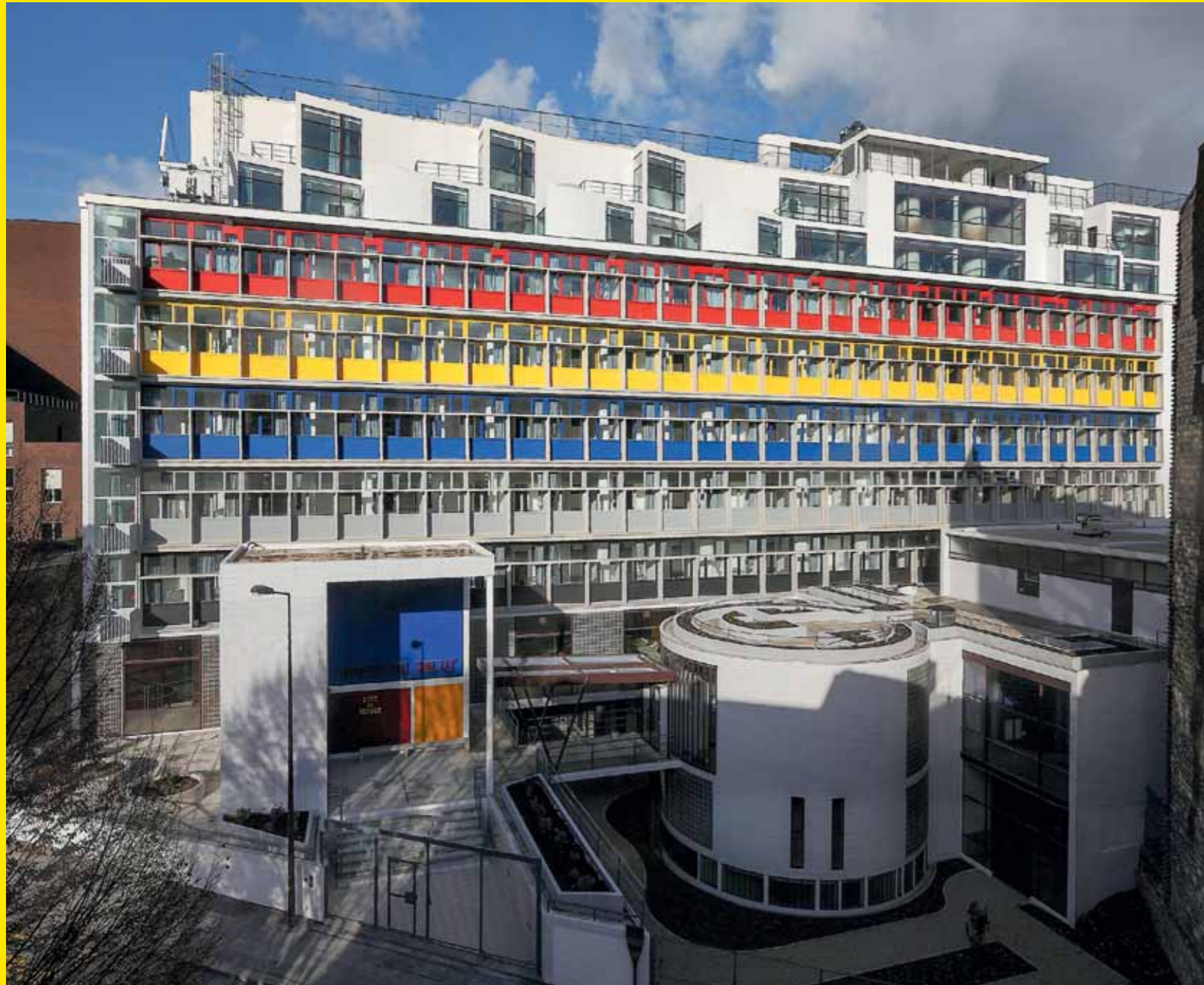
Das erste Großprojekt Le Corbusiers wurde nach langen Diskussionen umgebaut und saniert. Das Gebäude dient weiterhin als Unterkunft für Bedürftige. Foto: Olivier Wogenscky
