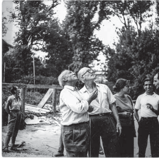
Le Corbusier und Picasso auf der Baustelle der Unité d'habitation in Marseille, 1949
