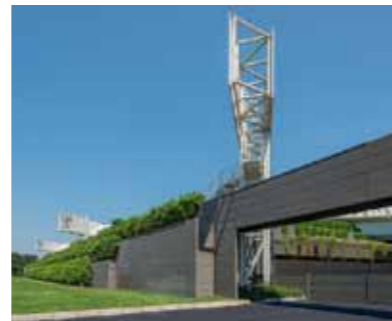
Die obere Halle wurde um 45 Grad gedreht auf die untere gesetzt. Die Rohre führen zur Klimazentrale ins Dachgeschoss. Skizze: Studio Canali
