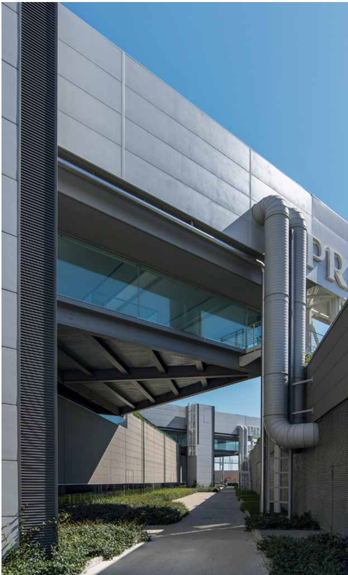
Die obere Halle wurde um 45 Grad gedreht auf die untere gesetzt. Die Rohre führen zur Klimazentrale ins Dachgeschoss. Skizze: Studio Canali
