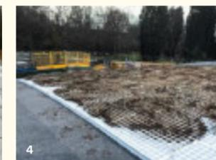
1 Der Kuppelbau aus Stahlbeton verschwindet unter einem Bauder-Systemdach. 2 Die Rundung der Kuppel war eine Herausforderung bei den Verlegearbeiten. 3 Schubschwellen im Beton verhindern ein Abrutschen der Dämmung. 4 Unter der Vegetationstragschicht wurden Wasserspeicherplatten mit einer Drainage Funktion verlegt.
