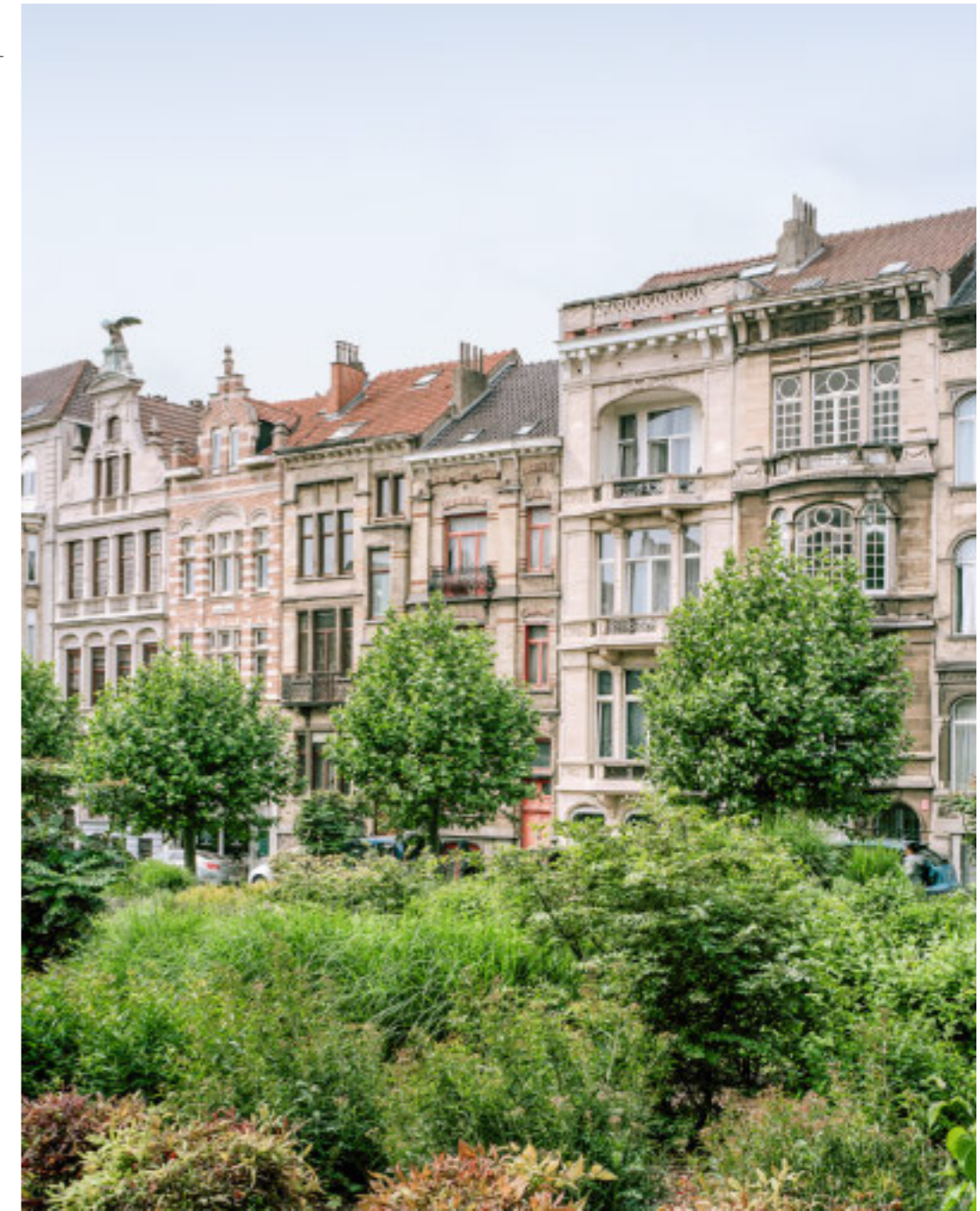
Links: Eckbebauung von 2015, Rue François-Joseph Navez im Stadtteil Schaerbeek von LOW architecten. Foto: Stijn Bollaert
